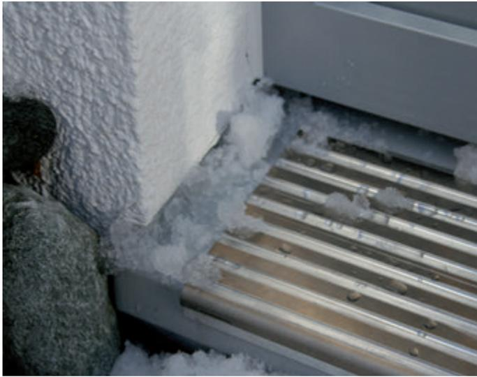
Es werden Fensterbänke aus stranggepresstem oder gekantetem Metall mit geringen Neigungsflächen für Fenster und Fenstertüren angeboten, welche eine glatte oder gering strukturierte Oberfläche haben. Diese Oberflächen bieten keine ausreichende Sicherheit beim Betreten und geben insbesondere bei Nässe und Frost für den Fuß wenig Halt – Abrutschgefahr.
