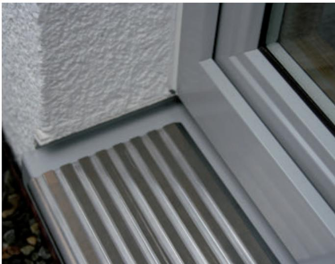
Durch diese Längenbegrenzung ist auch sichergestellt, dass handelsübliche Fensterbankabschlüsse verwendbar bleiben und ihre Dichtfunktion zum Mauerwerk erhalten. Des Weiteren steift das Trittschutzprofil die Fensterbankfläche gegen Gewichtslasten aus und ist bei Beschädigungen leicht austauschbar, was bei ungeschützten und eingeputzten Fensterbänken nur mit erheblichen Aufwendungen wie Putzerneuerungen möglich ist.
